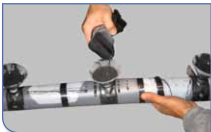
Соединительная гибкая заливная муфта 3М™ Scotchcast™ 92-AV 524
